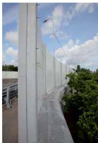
Шумозащитные экраны **Kraft SPAN BARRIER** могут эксплуатироваться в условиях открытого атмосферного воздействия при температуре от  $-60^{\circ}\text{C}$  до  $+45^{\circ}\text{C}$  и относительной влажности 75% при температуре  $+15^{\circ}\text{C}$  (климатические условия УХЛ-1 ГОСТ 15150-69).
